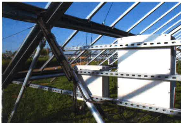
Figura nr. 17: Exemplu de montaj al invertorului pe structura de sustinere
